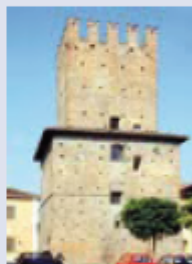
La torre Pusterla
